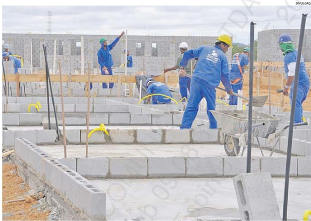
CONSTRUÇÃO DE MORADIAS: governo federal vai usar verba financiada pelo FGTS e o Orçamento Geral da União
