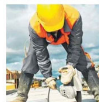
TRABALHO na construção civil
