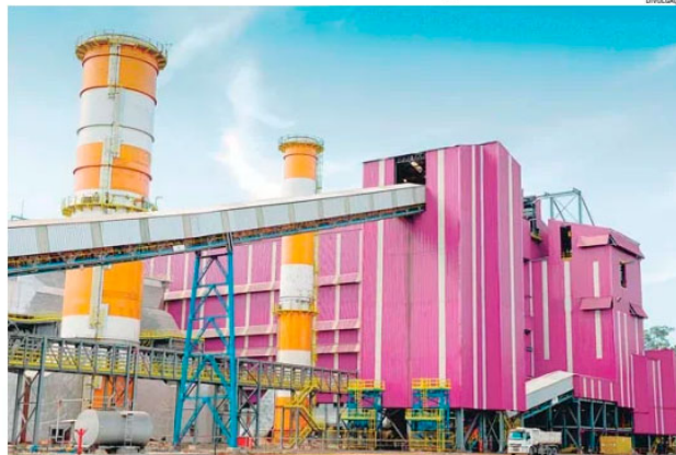
USINA de poluição da Vale em Tubarão: siderúrgica deve ter uma estação para utilizar água de esgoto tratado
