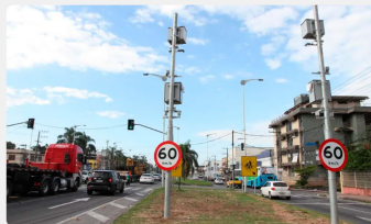
BR-301 na Serra municipalização | Foto: Kadlêa Fernandes/AT
