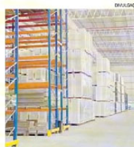
GALPÃO na Grande Vitória
