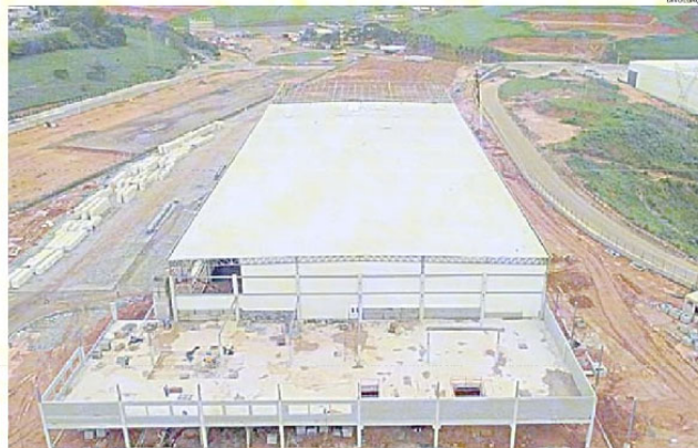
NOVO CENTRO DE DISTRIBUIÇÃO do Extrafruti, no Parque Industrial, em Areinha, Viana, está em construção
