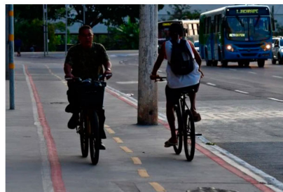
Poste no meio da ciclovia na Ilha do Príncipe, em Vitória. Crédito: Fernando Madeira
