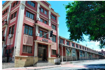
Fachada do Porto de Vitória e Armazéns da Codesa. Crédito: Divulgação/CASACOR
