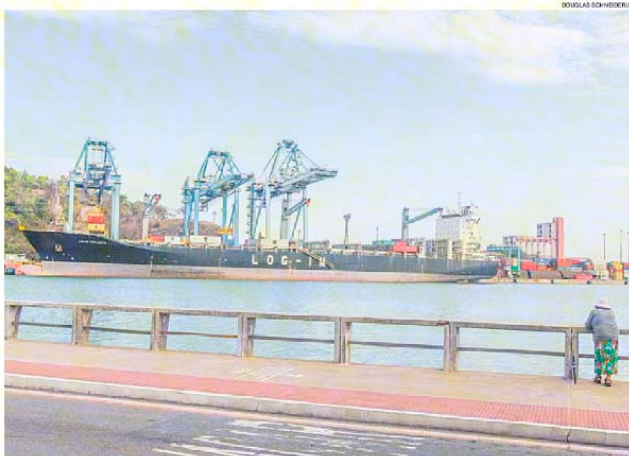
PORTO PÚBLICO em Vila Velha visto da avenida Beira-Mar: investimentos em logística e habitação a caminho
