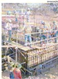
CANTEIRO DE OBRAS: trabalho
