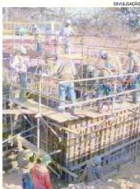
CANTEIRO DE OBRAS: trabalho
