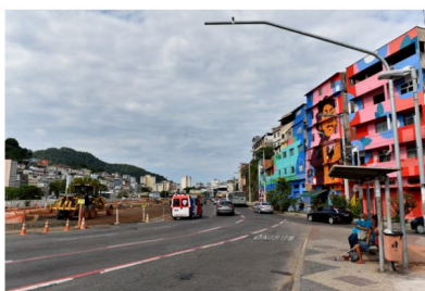
Construção do Portal do Príncipe, em Vitória. É uma das obras que vão contribuir para a melhoria da mobilidade. Crédito: Fernando Madeira
