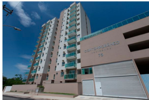
Press Contemporâneo Residence da CG Engenharia, localizado na Serra. Crédito: Cacá Lima
