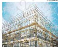
CONSTRUÇÃO de imóveis
