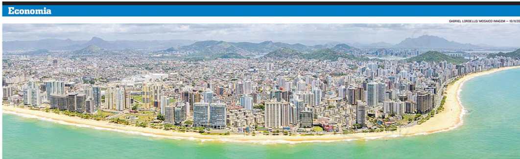
VISTA DO LITORAL de Vila Velha: município se destaca frente aos demais pela disponibilidade de terrenos em áreas urbanizadas, daí a concentração maior de lançamentos do mercado imobiliário
